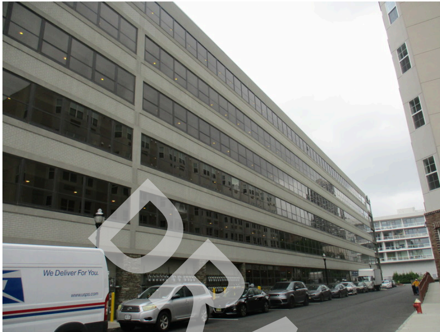
43. Adjoining east parcel
